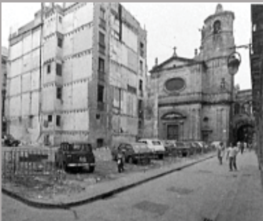
Fig. 1. Demolición de la manzana de casas para convertirla en la Plaça de la Mercè. Imagen: Acebillo, A., 2000.
