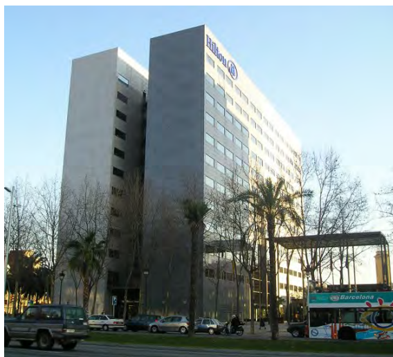
fig. 2.46 Plazoleta Hotel Hilton Barcelona.
