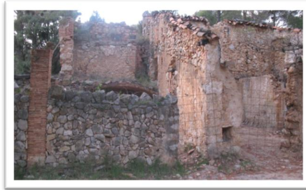
Fig. 21. Exterior de la rajoleria. Foto: Montse Gisbert
