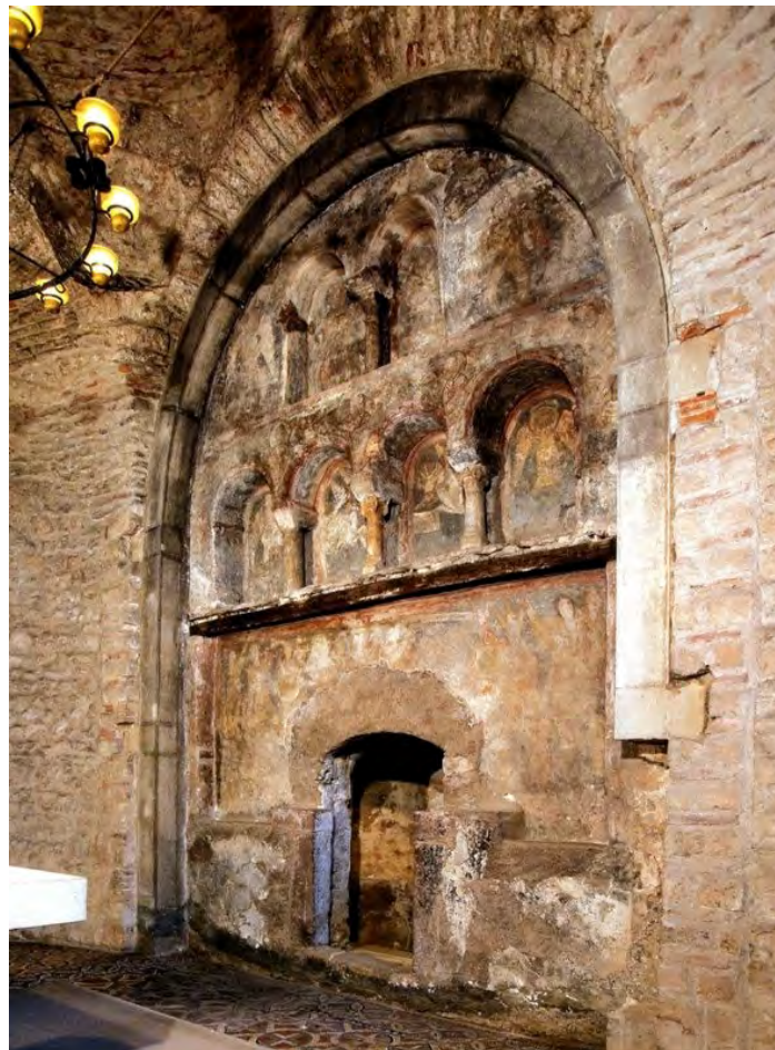
Fig. 26. Lòbul central de l'edifici parroquial de Sant Pere amb el retaule petri.
