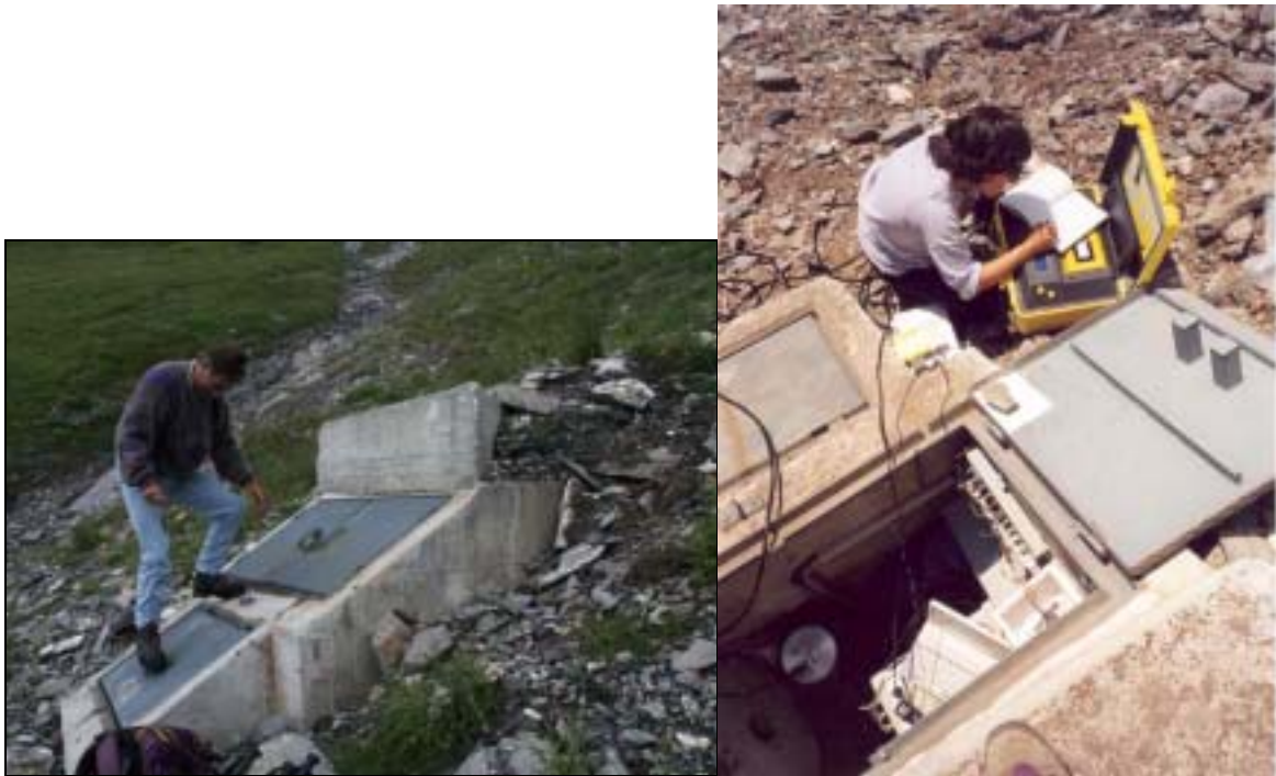
Figura 4-11. Caverna situada a 1900 m s.n.m, emplazamiento B de Vallée de La Sionne. En esta caverna se instalaron los sensores sísmicos y otros instrumentos de control. Fotografías realizadas por Glòria Furdada Bellavista.
