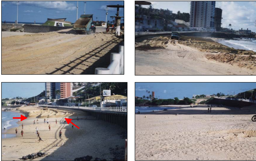
Figura 99 – Vista dos trabalhos de engorda na Praia de Areia Preta.
