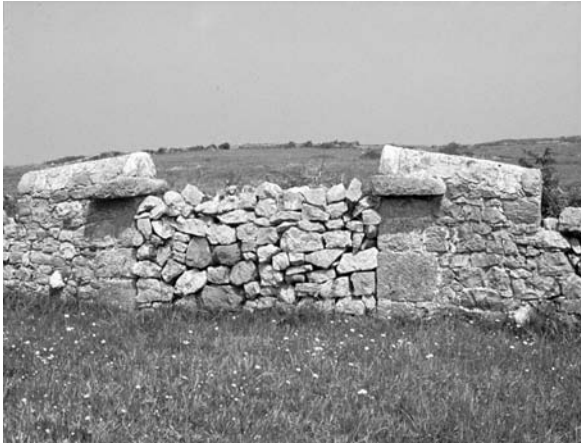
Porta tapiada. La pedra i la mà de l'home omplen de contingut el paisatge. Cantabria, 1976.
