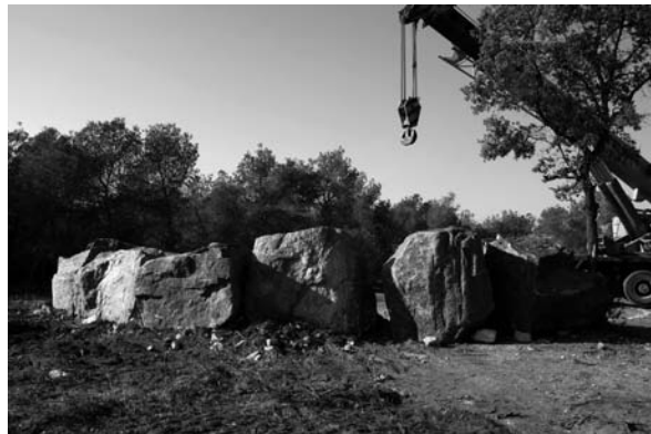
Construcció de l'anell. 2001
