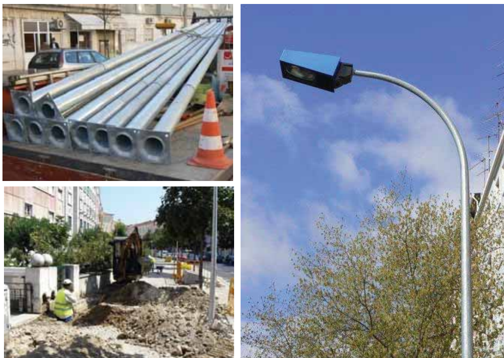
Figura 16: Abate dos candeeiros originais dos anos 40 e a sua substituição por novos postes de iluminação em chapa galvanizada (acedido em: 7 Abril 09, em: http://cidadania.lx.blogspot.com )
