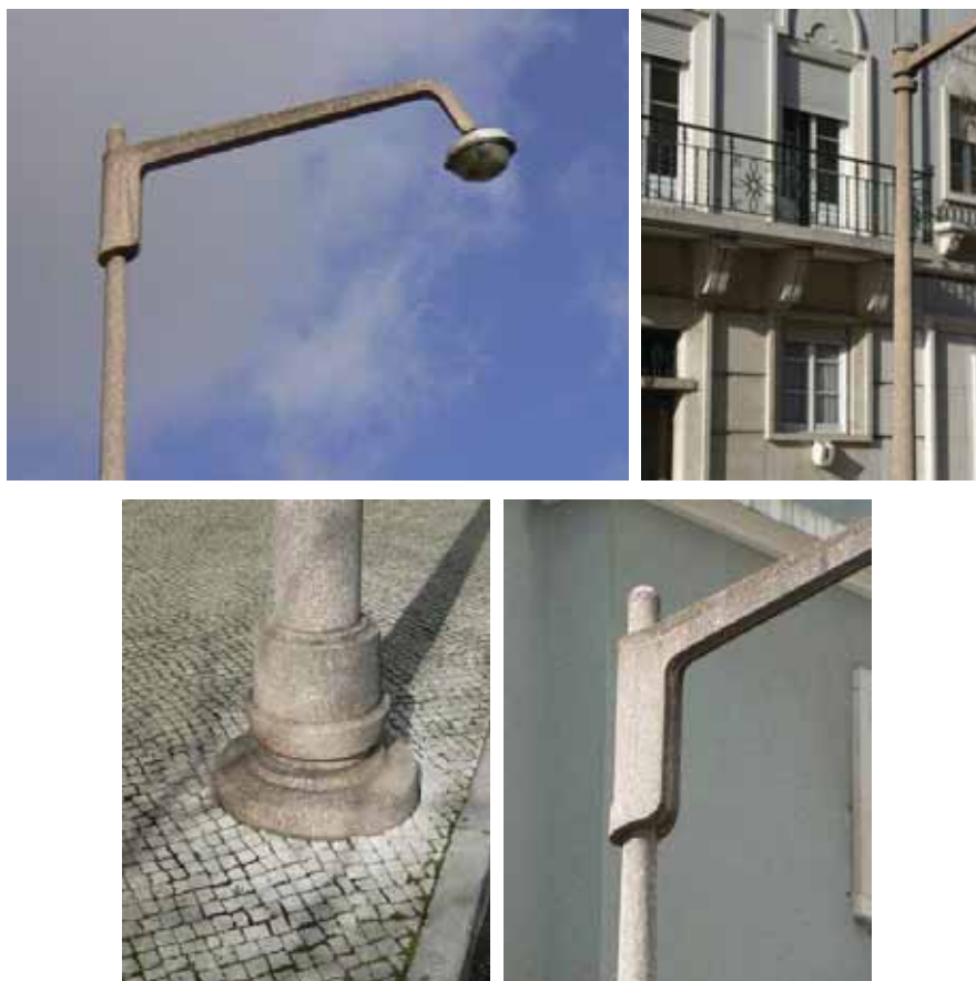
Figura 15: Pormenores dos candeeiros originais dos anos 40 na Freguesia de São João de Deus (acedido em: 7 Abril 09, em: http://cidadania1x.blogspot.com )
