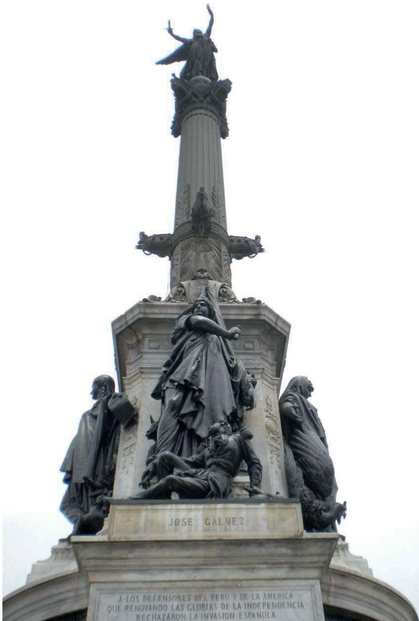
Figura 18. Vista del Monumento.
