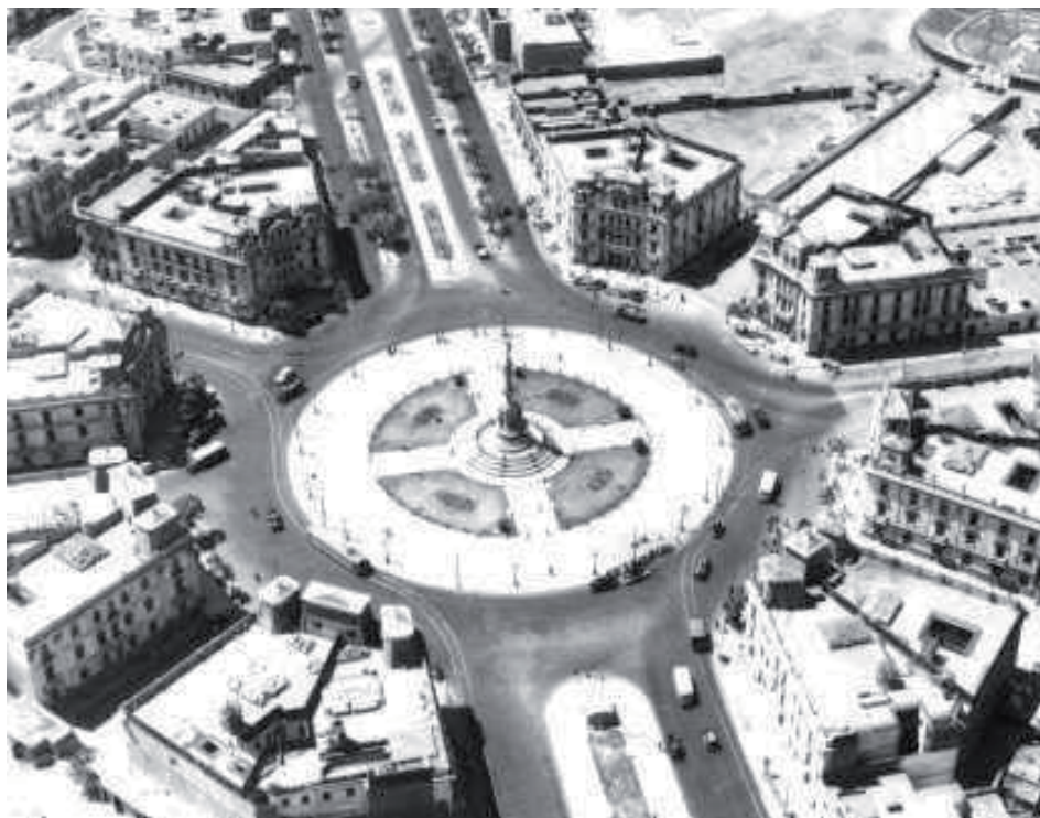
Figura 136. Vista aérea, nótese la planta circular de la Plaza.
