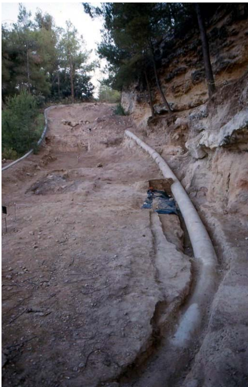
Fig. 30: Vista de la terrassa intermèdia a l'inici dels treballs d'excavació, el 1987.
