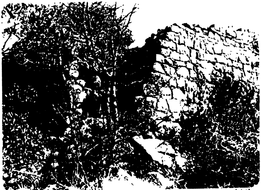
Mur de migjorn vist de l'exterior FIG. 468
