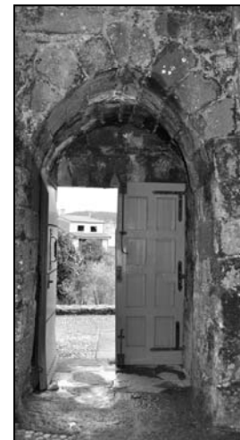
Fig. 73- Acceso de B desde el interior
