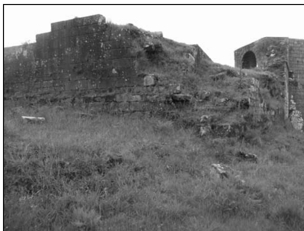
Fig. 93-Adosamiento de la cerca a la torre principal. Al fondo B1.
