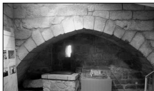
Fig. 78- Arco apuntado de descarga en el interior de F
