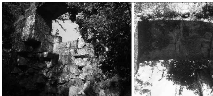
Fig. 66- Detalles de la ventana de A desde el interior.
