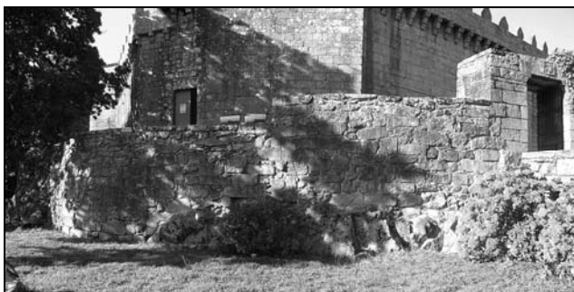
Fig. 81- El muro de contención al lado del acceso a la fortaleza evidenciando varias reformas.
