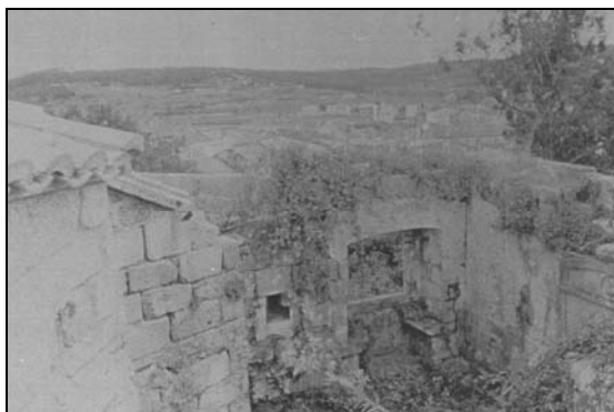
Fig. 86- Vista del sector D antes de la restauración, a la derecha decoración en el lienzo sur (SADAC)
