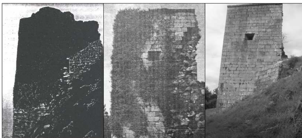
Fig. 105- El sector B1 a principios del XX (TETTAMANCY, F., 1917b), antes de la restauración (COOPER, E., 1980-1981) y en la actualidad. Nótese los restos conservados de la unión con otra estructura que desaparecen con las obras.
