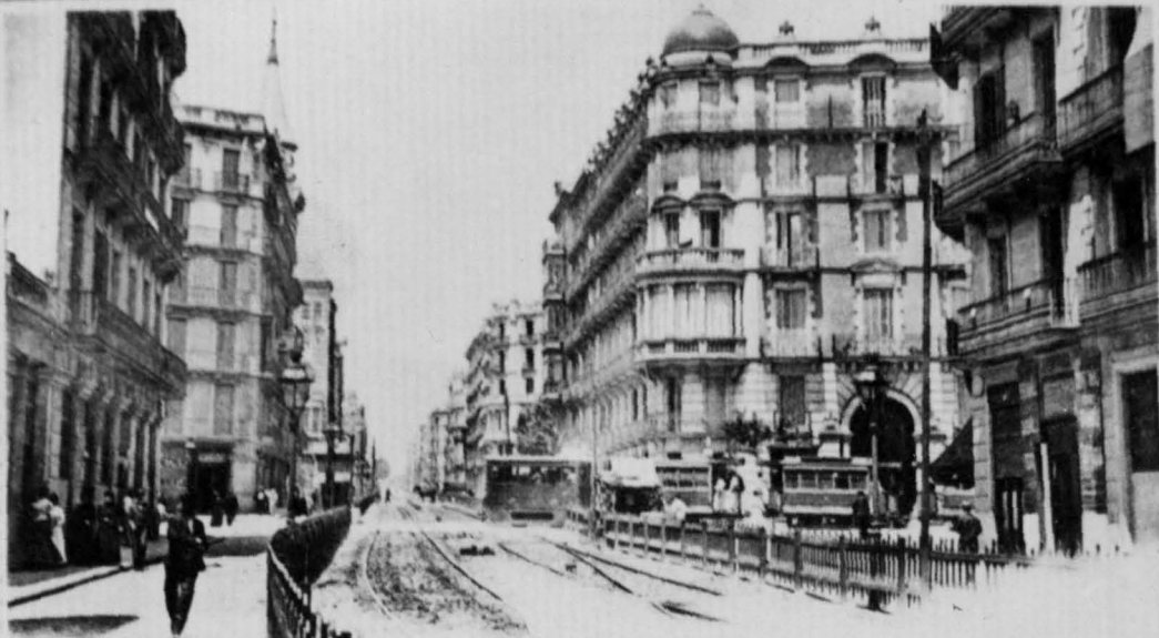
BARCELONA CALLE DE BALMES 934 Hauser y Menet. - Madrid
