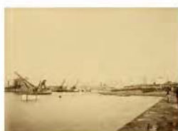
Varaderos provisionales de lanchas y gabarras
