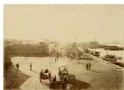
Nuevo muelle de la Barceloneta. Vista tomada desde la Machina hacia su extremo Sur
