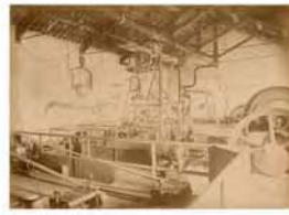
Túnel de Argentera. Ataque del stress
