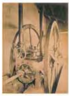
Túnel de Argentera. Compresor
