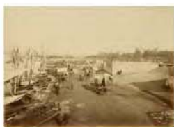
Nuevo muelle de la Barceloneta. Vista tomada desde la Machina hacia su extremo Norte
