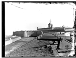
Una batería en el Castillo de Montjuich
