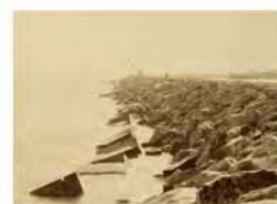
Dique del Este. Vista exterior en el arranque
