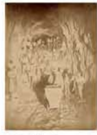
Túnel de Argentera. Ataque del stress
