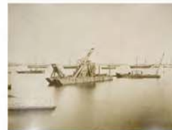
Tren de limpia y cabria flotante
