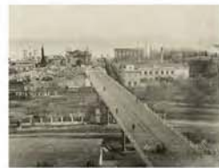
Sección Marítima. Viaducto
