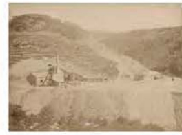
Túnel de Argentera. Caldera del compresor
