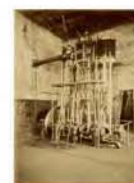
Máquina motriz para la producción de la fuerza hidráulica
