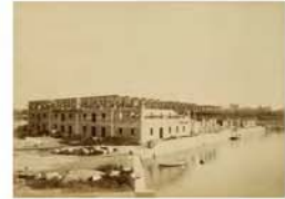
Depósito Comercial (en construcción). Fachada principal o del lado del mar
