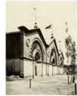
Galería de Máquinas
