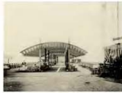
Muelle de la Sección Marítima
