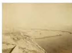
Vista general del puerto, en su estado actual de construcción (Enero de 1897)
