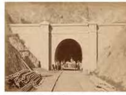
Túnel de Argentera. Boca de salida
