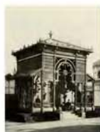
Instalación al aire libre
