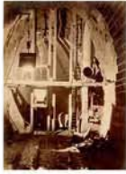
Túnel de Argentera. Instalaciones del pozo número 4 dentro del túnel
