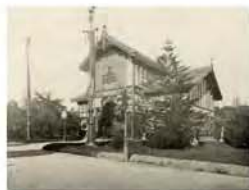
Instalaciones al aire libre. Pabellón del Marqués de Campo
