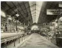
Galería de Máquinas. Interior
