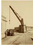
Grúa hidráulica de 25 toneladas
