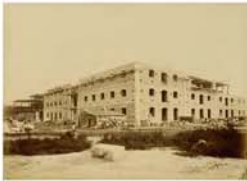
Depósito Comercial (en construcción). Fachada posterior
