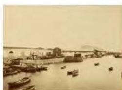
Muelle Nuevo. Dársena de la Industria
