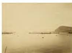
Vista general de la boca exterior y de las actuales dársenas
