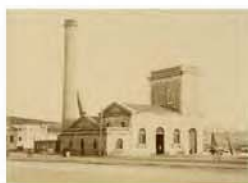
Casa de Máquinas del material hidráulico. Vista exterior
