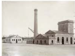
Casa de Máquinas. Taller de reparaciones y grúa de 25 toneladas
