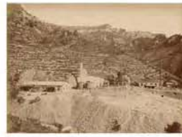
Túnel de Argentera. Boca de salida
