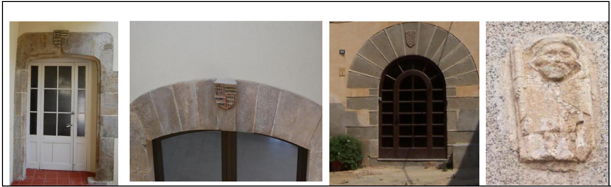
Portes de la rectoria d'Alella amb l'escut del Canonge Desplà, porta de Can Mora de Teià i detall del relleu de la porta de la masia de Can Monar de Teià.
