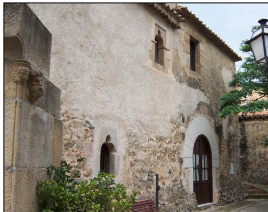
Can Destorrent (Teià) Façana de la masia [Fot. J.Graupera]
