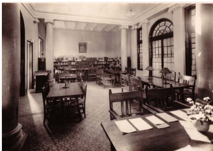
Fig. 14. Vista general de la sala de lectura de la biblioteca de Canet. Font: Arxiu Canet
