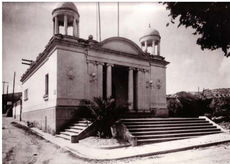
Fig. 8. Edifici de la biblioteca de Canet. Font: Arxiu Canet
