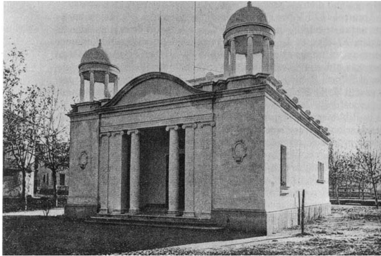
Fig. 7. Edifici de la biblioteca de les Borges Blanques. Font: C. de Balanzó, op.cit. , entre les p. 48 i 49
