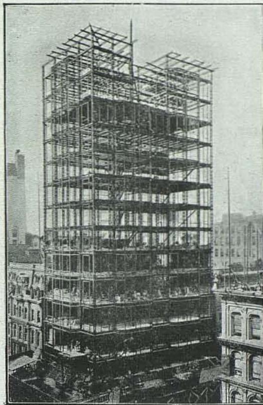
Fig. 52. Progreso en el montaje del edificio de la figura anterior, experimentado en el espacio de 14 días
