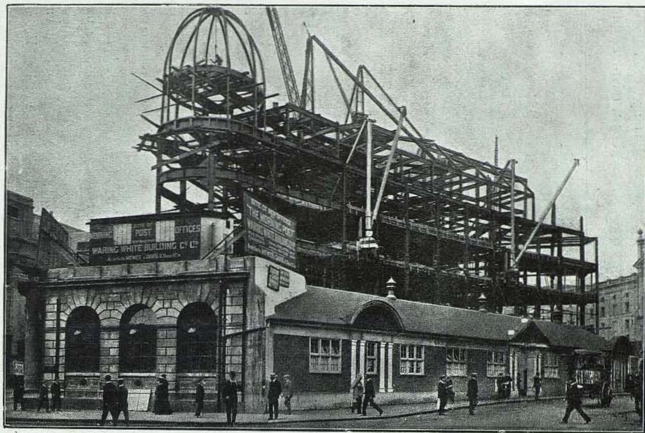
Fig. 53. «Skeleton» metálico del «New Morning Post», Londres
