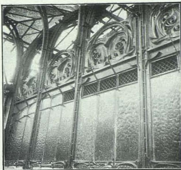
Fig. 73. Armonía decorativa resultante de la combinación entre la fundición, el vidrio y el hierro laminado
