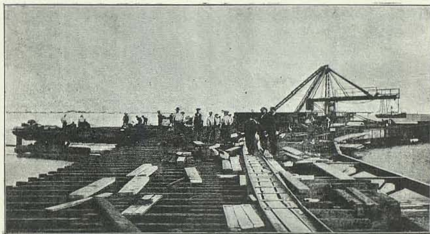
Fig. 31. — Grúa de servicio empleada en la colocación del tablero metálico del «Appontement de Pouillac»
