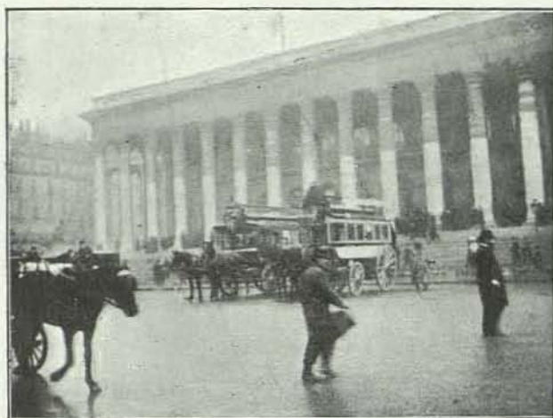
Fig. 11 —Estructura pétreo arquitrabada —«La Bourse», París
