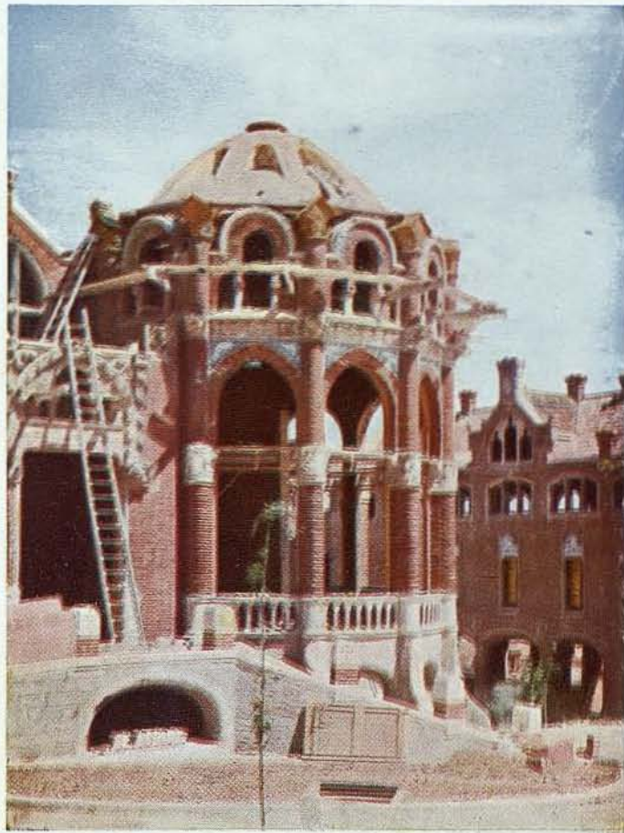
Rotonda de uno de los pabellones del Hospital de San Pablo; Barcelona — Arquitecto: Doménech y Muntaner
