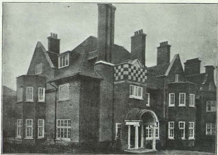
Fig. 10.—Rathmore; Eton Avenue, Londres, N. W. — Construcción en Fort Stone
