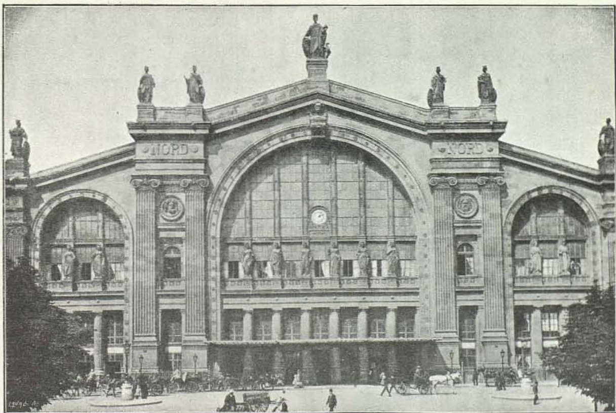
Fig. 15. — Tratamiento arquitectural de la « Gare du Nord », Paris
