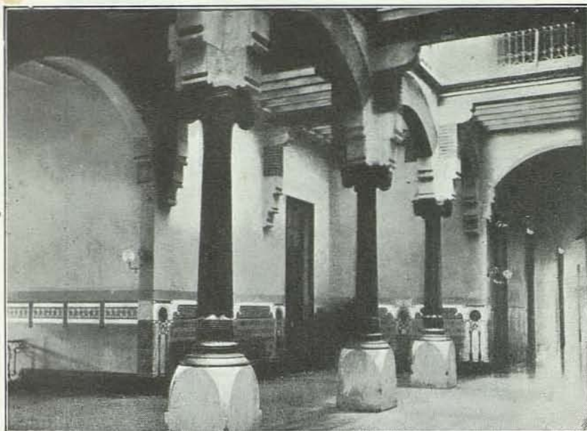
Fig. 19 — Serie de columnas de fundición que sostienen los arcos de ladrillo del patio de la Casa de Matrnidad. — Barcelona.
