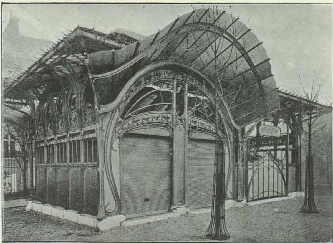
Fig. 22 — Combinación artística de hierro laminado, fundición y vidrio. — Estación de «l'Etoile», Metropolitano de París
