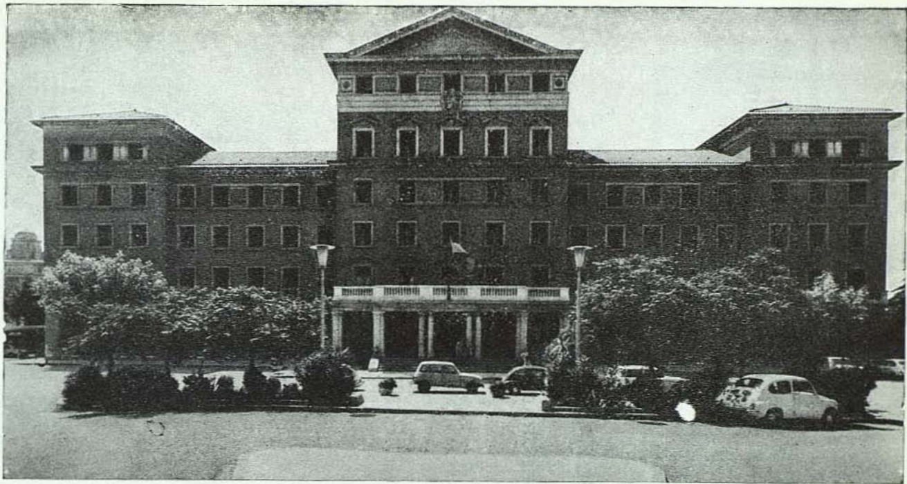
Edificio de la Facultad de Farmacia, situado en la zona universitaria de Pedralbes.
