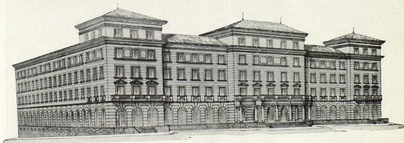
Facultad de Farmacia. Perspectiva del nuevo edificio en construcción
