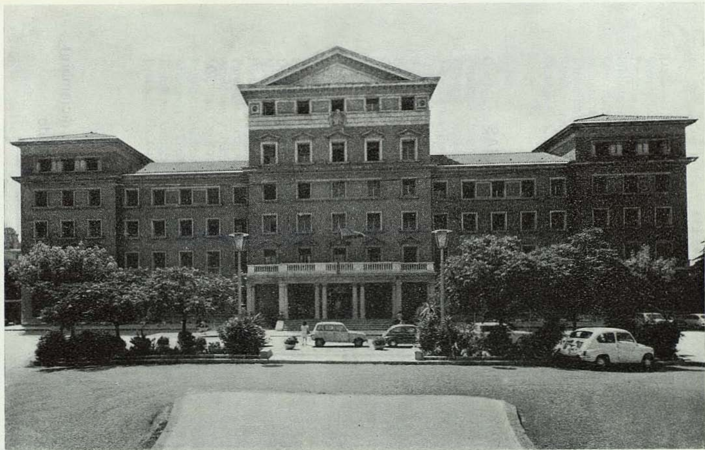
Edificio de la Facultad de Farmacia, situado en la Zona Universitaria de Pedralbes.
