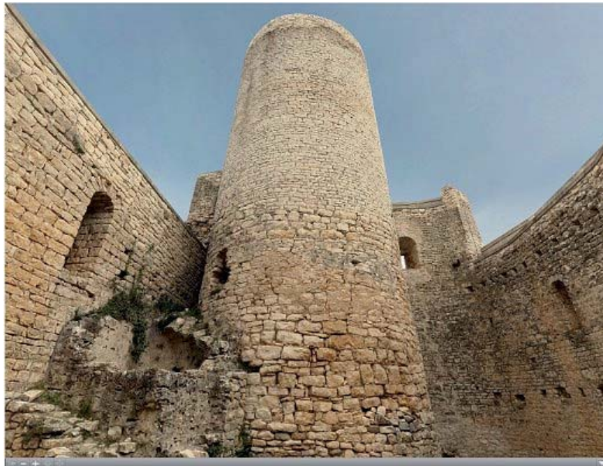
Figura F3-6. Quick Time: Vista de la torre des del pati. S'hi observa a l'esquerra de la torre la cisterna en ruïna i a la dreta uns forats d'embigats que denoten que hi havia un edifici annex a la torre. 30
