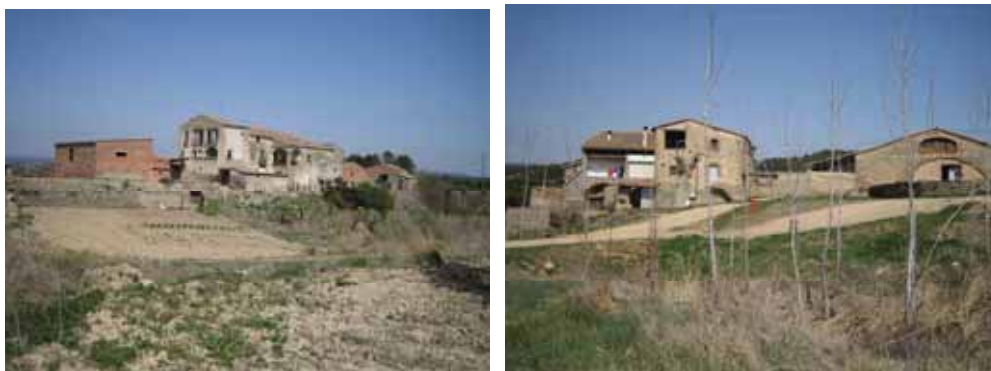
Foto n. V.53 Soler x: 411.636; y: 4.623.274. Habitada i feines de pagès Foto n. V.54 L'Angla x: 410.782; y: 4.623.461. Habitada i feines de pagès
