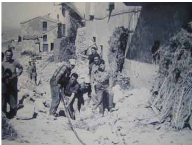
Foto n. V-18 Obres per a la instal·lació de l'aigua al carrer de Manresa, els anys 30'
