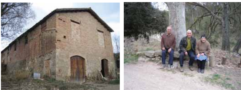
Foto n. V.13 Restes de les instal·lacions industrials de Bellveí. Aquest edifici, avui encara dempeus, era destinat a garatge dels carros a la planta baixa i sala de ball de la colònia, a la primera planta.
