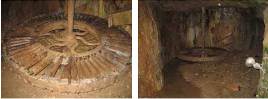
Fotos n. III. 3.4 Turbina d'un molí hidràulic en desús, però en bon estat de funcionament. Es tracta del molí de Puigoriol, a la riera de Lluçanès, al Lluçanès, a la comarca d'Osona, just al límit d'aquesta amb el Berguedà. És similar a les que equipaven els molins del Moianès
