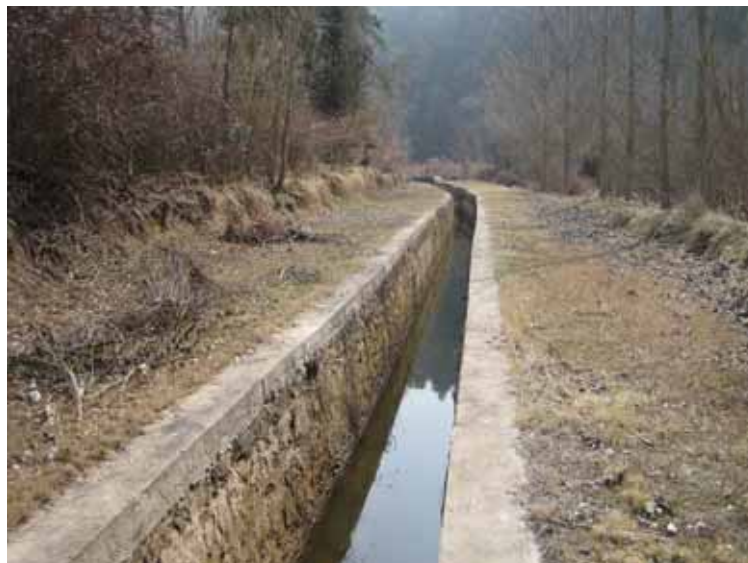
Foto n. III.61 Canal de la central de Jorba. Es veu perfectament el seu recorregut degut a un bon manteniment de la traça. Es pot veure que el seu cabal és de l'ordre del 10 % de la seva capacitat, degut al poc volum del riu en aquestes dades
