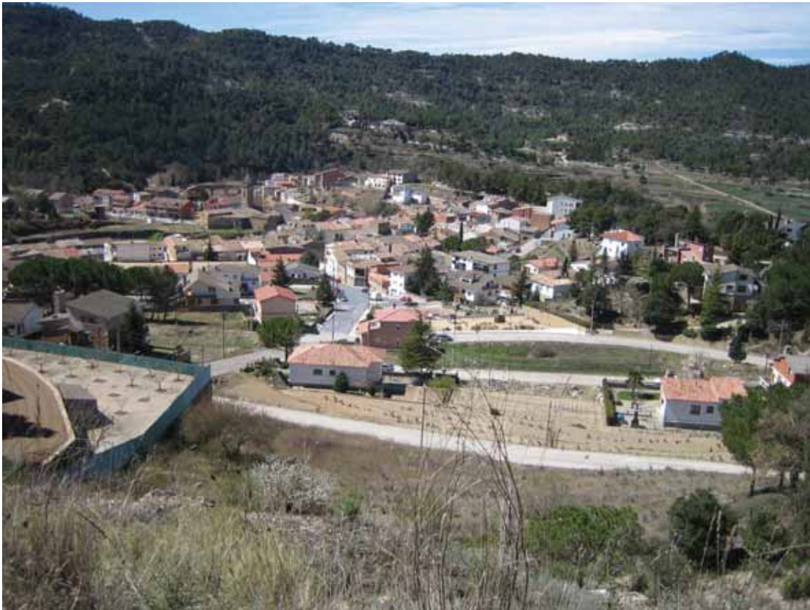
Foto n. III.40 Vista parcial de Monistrol de Caldes, des de llevant, amb el serrat de la Musarra al fons i la trama fluvial al fons de la vall. També la carretera de Calders a Sant Llorenç Savall passa, en aquest tram, pel tàlveg.
