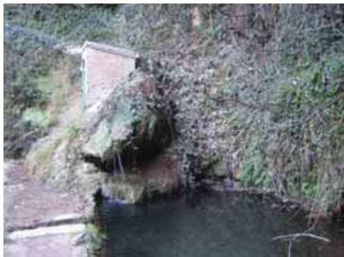
Foto n. III.77 Detall de l'habitacle on hi ha la bomba d'ariet. Es pot veure la canonada que li dona pressió, i a sota, el primer dipòsit des d'on impulsa l'aigua cap la masia de les Tàpies
