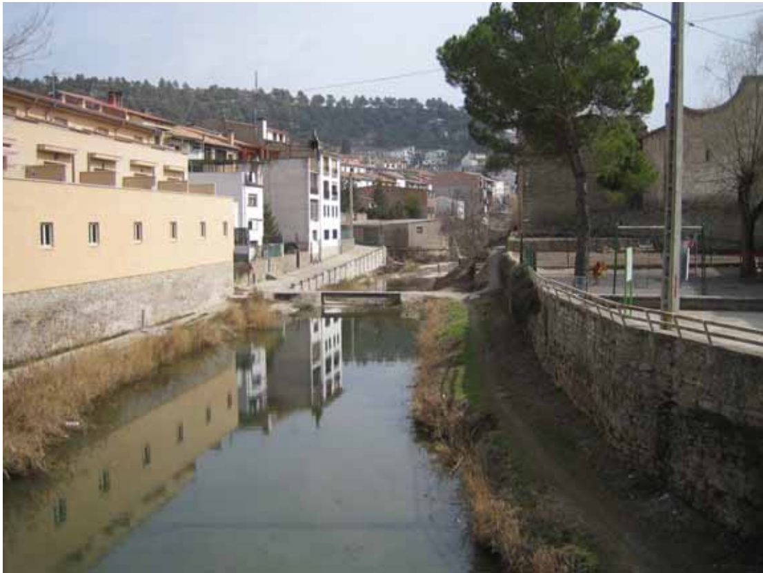
Foto n. III.42 Imatge de la riera de Sant Joan en el seu traçat urbà dins Monistrol de Calders. La foto està presa des del pont del rector, aigües amunt. La configuració de la llera i una petita presa, li dona una amplada d'aigua que no es correspon amb el cabal que sembla indicar i que en realitat és molt inferior.
