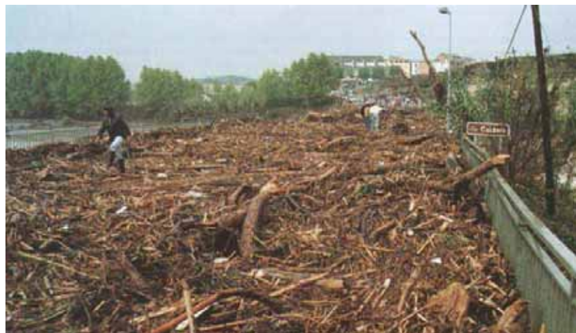
Foto n. III.83 Un altre detall de l'estat en què va quedar el pont sobre el Calders a Navarcles.
