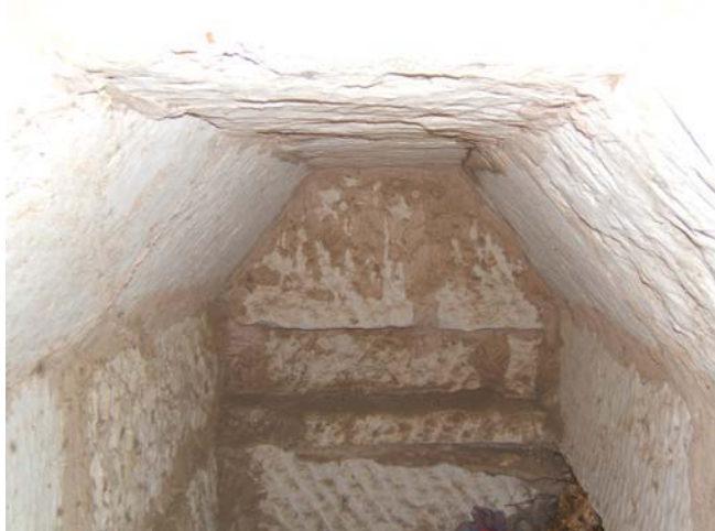
Fig. 114: Detall de la volta poligonal de l'annex de la tomba 1.
