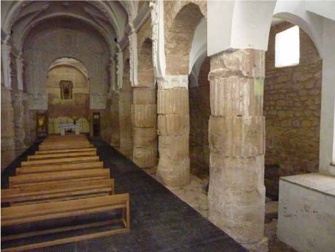
-Foto 37- Santa María de Arcos ( Tritium ). La iglesia tardoantigua aprovecha elementos arquitectónicos de un templo romano. Fotografía de J. Sales.
