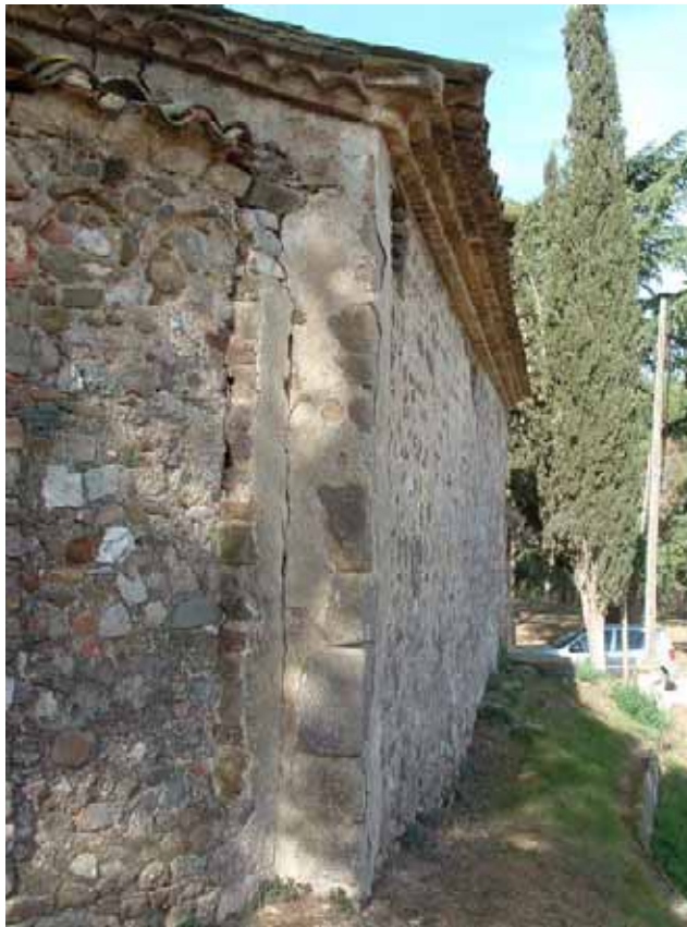
-Foto 18- Sant Miquel de Toudell (Viladecavalls, Barcelona). Detalle de la unión exterior entre el ábside y la nave, donde se observan los grandes bloques de piedra, muy probablemente de época romana, o pertenecientes a un edificio anterior al actualmente visible (fotografía de J. Sales).
