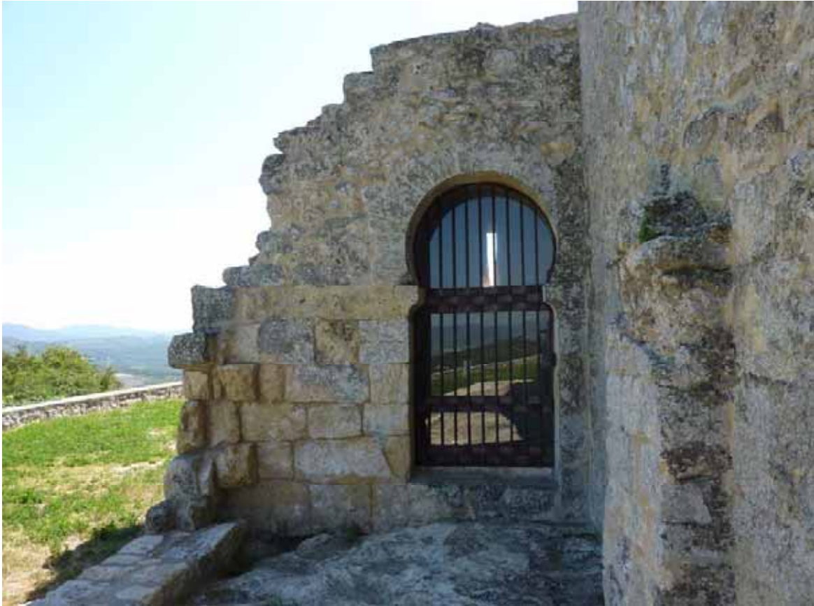
-Foto 35- Sant Miquel (Olèrdola, Barcelona). Detalle del arco de herradura (fotografía de J. Sales).
