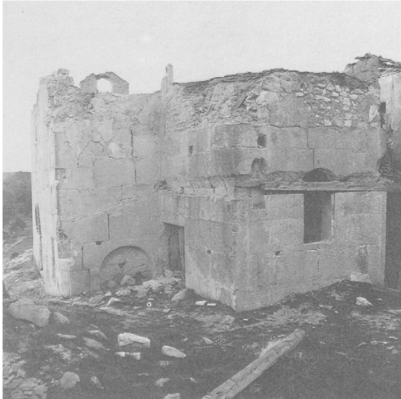
-Foto 11- San Pedro el Viejo de Arlanza, Hortigüela. Vista de la cabecera desde el lado Sudeste. (CABALLERO-CÁMARA, 1995: 86). Obsérvese el aparejo a base de sillares romanos reaprovechados.
