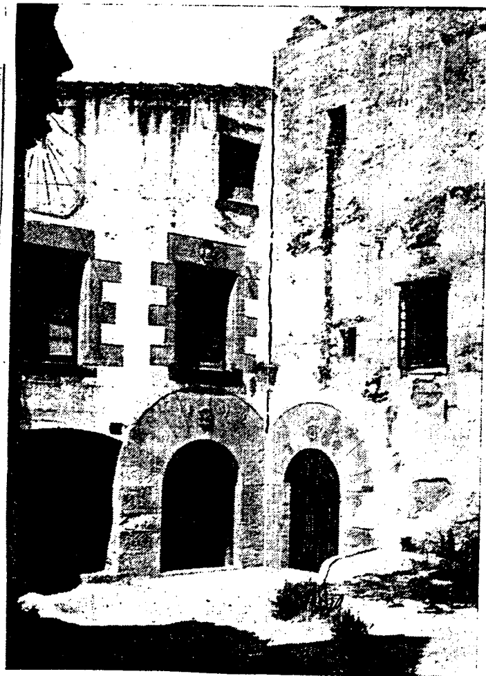
CASA RECTORAL AMB EL TÚNEL.
