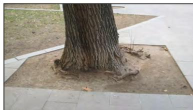
Alcorque no estandarizado, conformado por las losas de hormigón.
