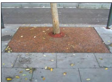
Alcorque estandarizado de perfil metálico y pavimento asfálticos de drenaje. Dimensiones: largo variable de 1.20 ó 1.80 m y ancho 1.20 m
