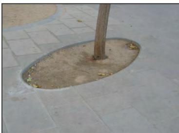
Alcorque no estandarizado, de perfil metálico. Dimensiones: 2,85 cm de largo y 1.00 m de ancho
