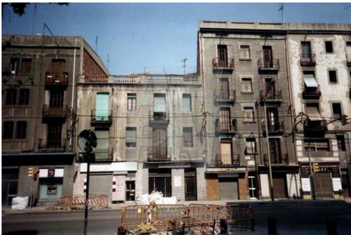
33 - Edificios destruidos en la calle Pere IV para la prolongación de la Rambla del Poblenou entre calle Pere IV y la Avenida Diagonal (1998).
