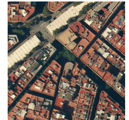
Vista actual del espacio público
