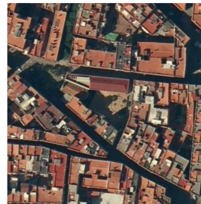
Vista actual del espacio público
