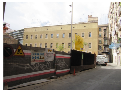
Imagen de obras que están realizando en la plaza
