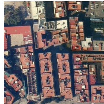
Vista actual del espacio público
