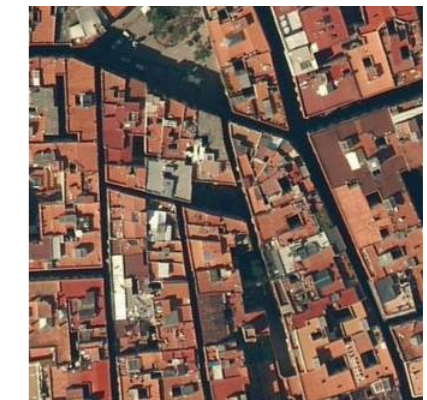
Vista actual del espacio público
