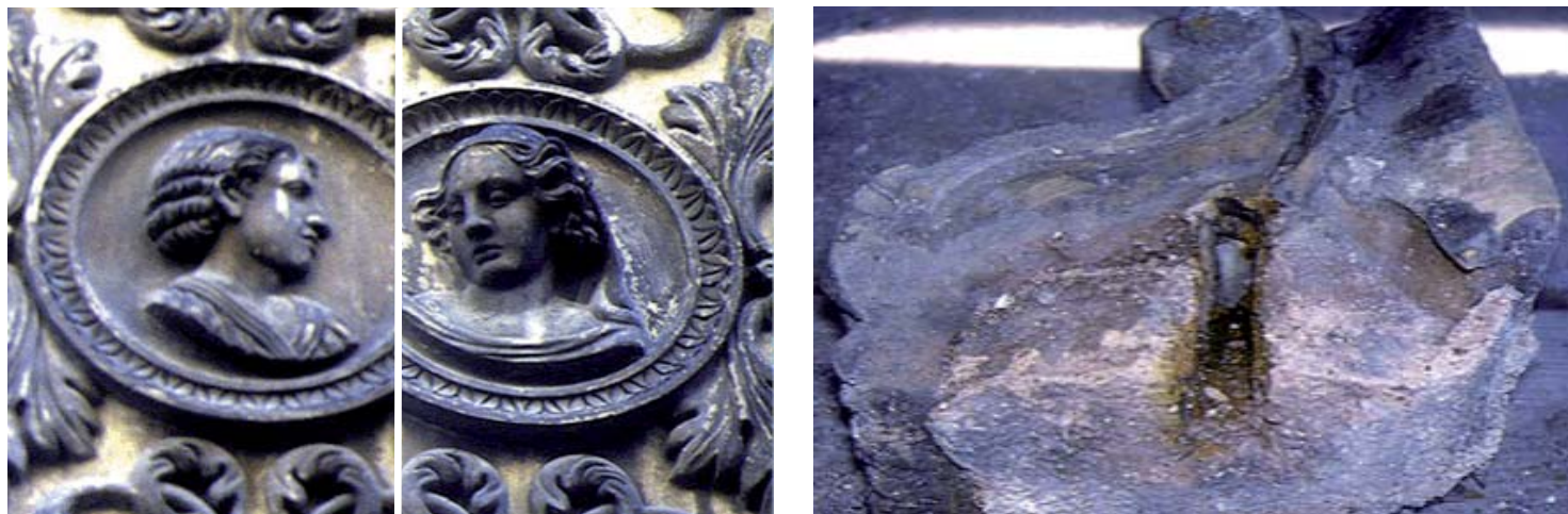
Figura 1. Elementos seriados. Carrer del Pi, 12 —medallones con base idéntica sobre la que se adhieren distintos rostros masculinos y femeninos— (izquierda). Carrer del Call, 15 —modillón realizado mediante molde de dos caras ensamblando ambas piezas con barbotina— (derecha).
