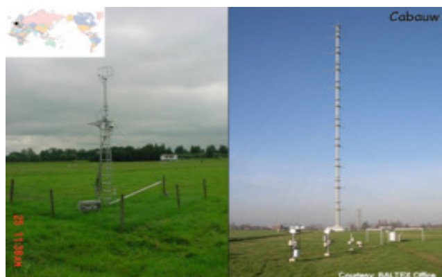
fig 1.b. A l'esquerra, la torre de mesura dels fluxos. A la dreta la torre principal de 213 m.
