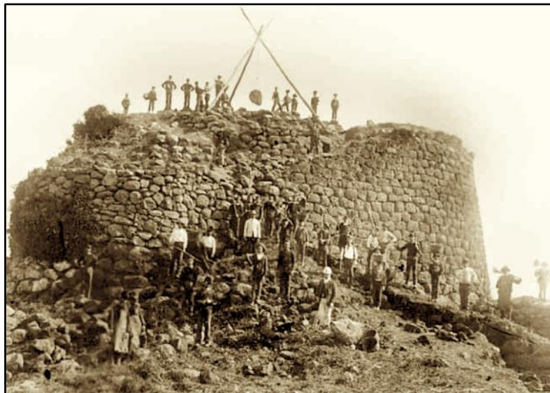
Fig.6 Primeres obres d’excavació al nuraghe Losa (Abbasanta), a f.s.XIX.
