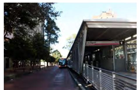
Imagen 7. Estacion sencilla TransMilenio en Bogotá.
