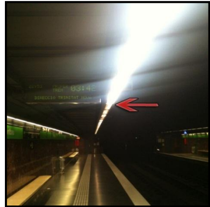
Figura 3. En la imagen observamos la estación de Montbau durante el proceso del cambio de lámparas. La flecha roja separa las lámparas nuevas recién instaladas de las pendientes de renovar.
