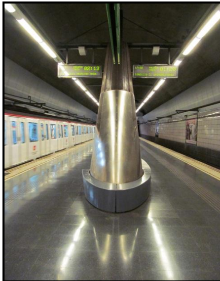
Figura 17.1. Zona del andén en la estación de Valldaura . La visibilidad se ve gravemente entorpecida por las columnas decorativas.
