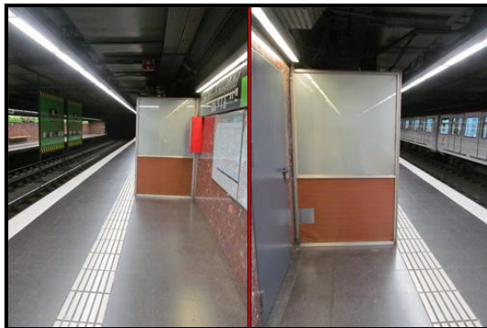
Figura 18. Zona del andén en la estación de Montbau . Resulta un ejemplo de obstaculización grave del campo de visión, reduciéndolo notablemente. En la fotografía podemos apreciar la visibilidad desde ambos lados del obstáculo.
