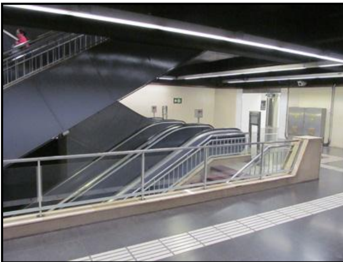
Figura 4.3. Foto de la Estación de Penitents (1985), correspondiente a la zona de transición desde la entrada/salida hasta el andén. Un único espacio pero con poca visibilidad y camino confuso.
