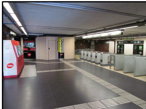
Figura 17. Vestíbulo de la estación de Montbau. La sala del jefe de estación no está orientada a las máquinas de entrada y salida, lo cual disminuye el control sobre las entradas y salidas.
