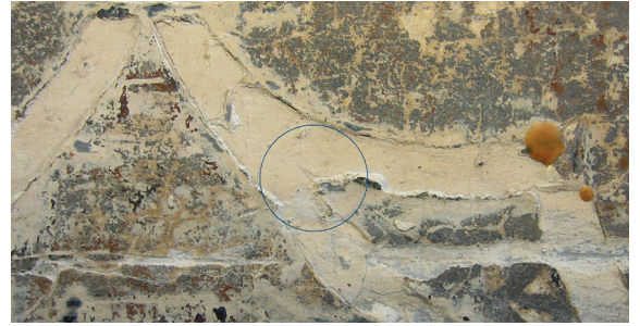
Fig. 9. Gelosia interior d'un arc trilobat. Trazos de dibuix amb estil metàl·lic tou / Celosía interior de un arco trilobado. Trazos de dibujo con estilo metálico blando.
