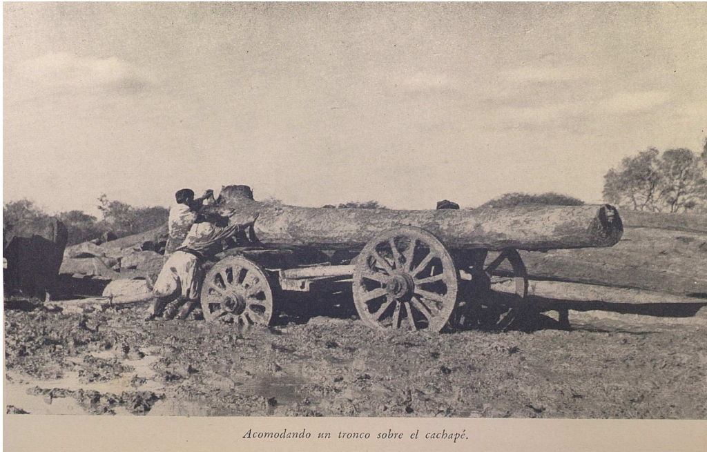
Imagen 2. Acomodando un tronco sobre el cachapé
