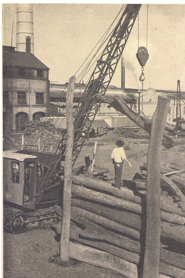
Descarga de quebracho a guinche de vapor en la fábrica de extracto.
