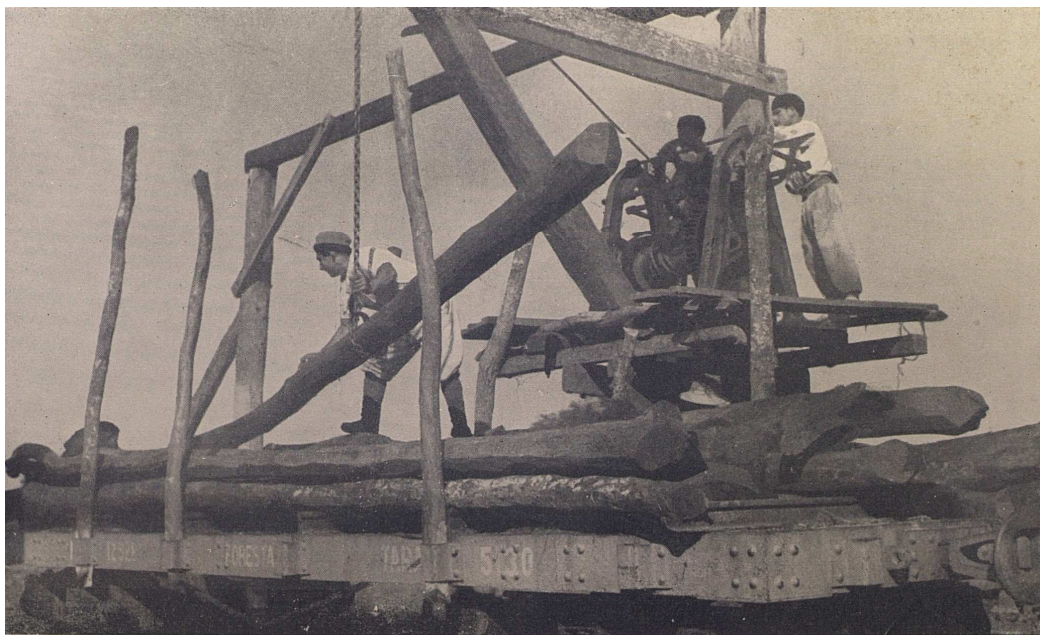
Cargada de una chata de vía mediante el guinche criollo.
