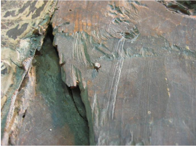
◀ Fig. 24. Detall d'una de les puntes corresponents al clavetejat realitzat en la part de l'anvers dels muntants per a subjectar la fràgil làmina de fusta a les posts.
