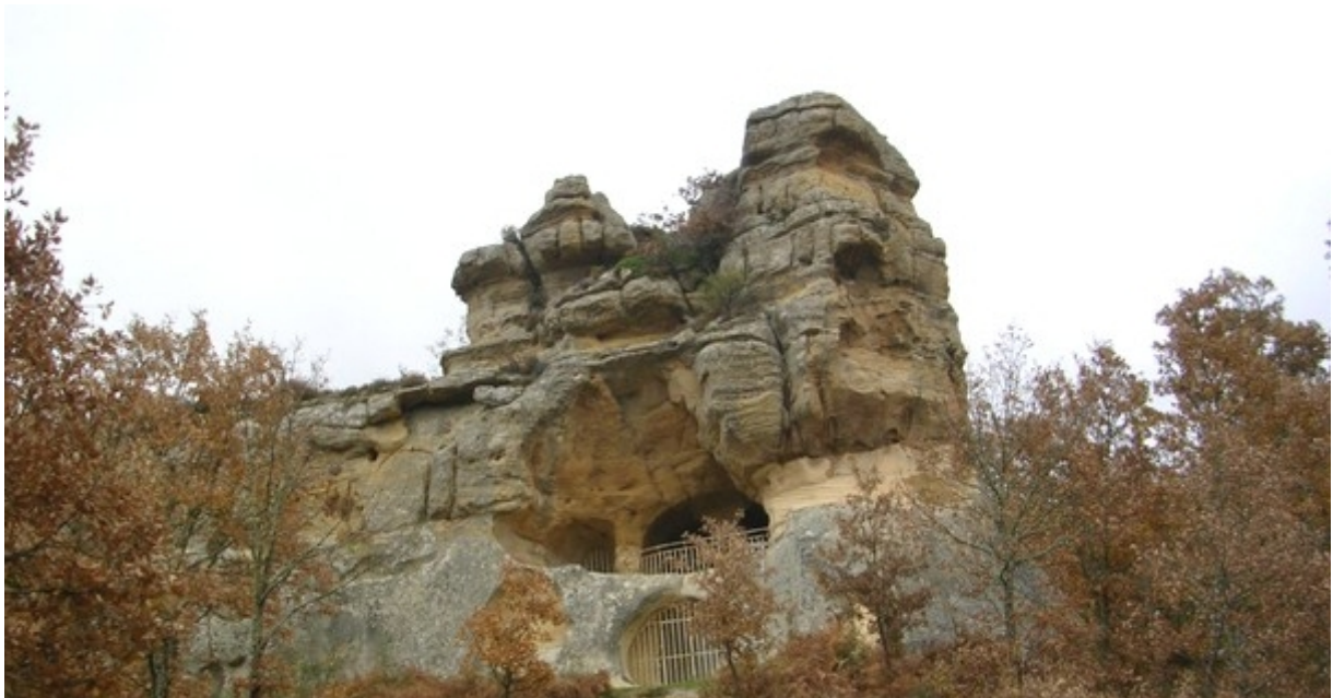
Fig. 14: Eremitorio rupestre de San Miguel de Presillas (Burgos). S. VIII. Extraído de: www.cantabriarural.com
