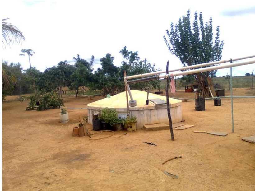
Foto 2. Cisterna para captação de água de chuva. Território de Irecê. Pesquisa de campo. Fonte: Gustavo B. Machado, 2012.
