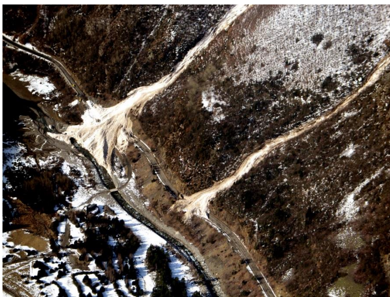
Foto 4: Foto aérea (2014) cedida por la Fundación Llanos del Hospital. Carretera A-139 cortada por aludes en la canal de Senarta 1 y Senarta 2.
