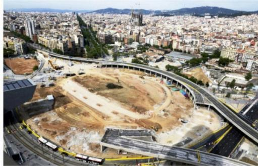
*Paralelamente al derribo del anillo viario se comenzó la construcción de las vías elípticas al interior.*
