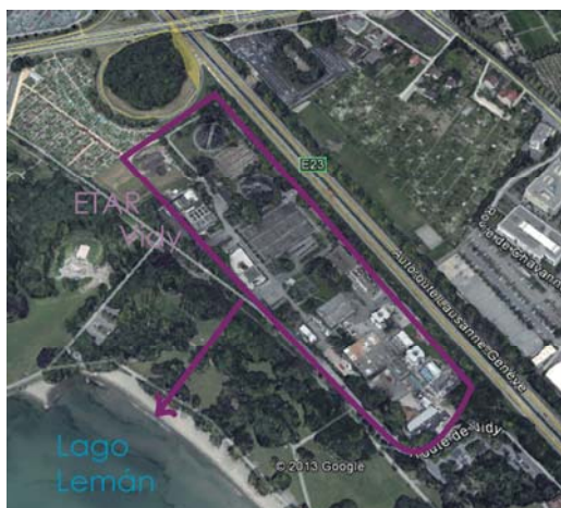
Fig. 4.23- Vista aérea de la ETAR de Vidy, Lausana (Suiza)
