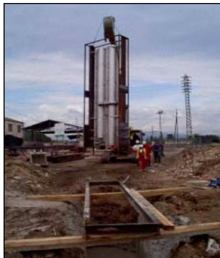
Imatges de la instal·lació de les portes filtrants.
