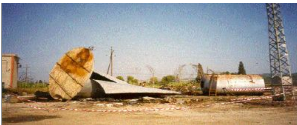
Imatge dels dipòsits i tancs presents a les instal·lacions de Clipper Oil, SA . Font: Junta de Residus
