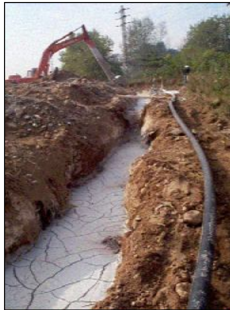
Imatges de la construcció de la barrera impermeable.
