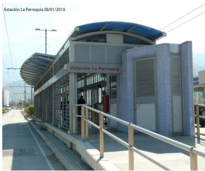
Estación Parroquia de la av. Andrés Bello
