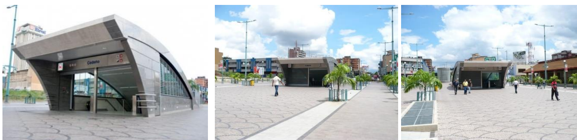
Figura 70: Estación Cedeño del Metro de Valencia
