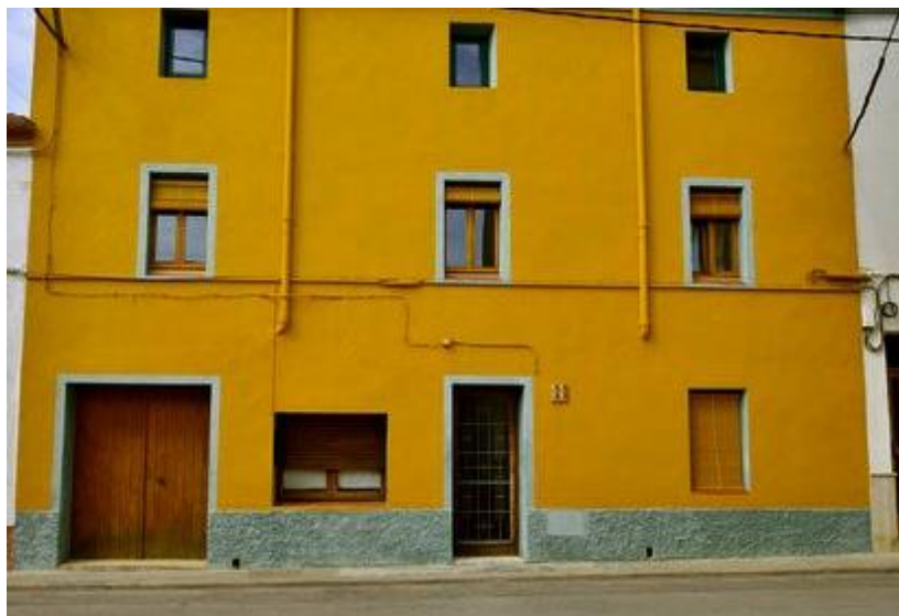
Figura 20: Fachada Casamarlès, sede de CeRCCa en Llorenç del Penedès. Fuente: CeRCCa en [24/05/2015] http://cercca.com/casamarles-3/
