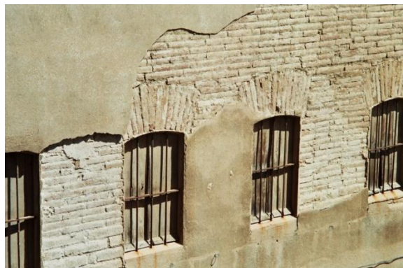
Disposició del maó formant els murs dels pisos superiors i el coronament de les ventanes (2006)
