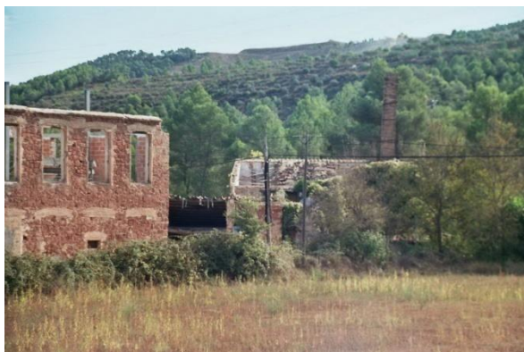
Recinte de Cap d'en Pont, amb la nau tèxtil a l'esquerra i el molí paperer al fons (s/d)
