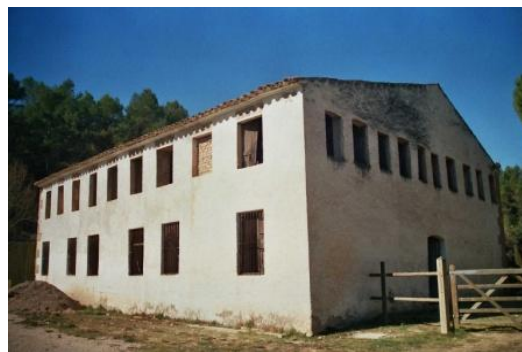
Construcció complementària adjunta (2005)
