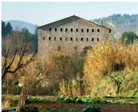
Façana posterior de l'edifici (2004)
