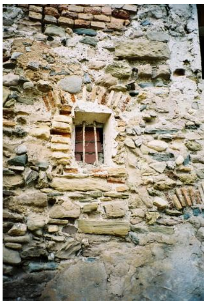
Materials de construcció originals
