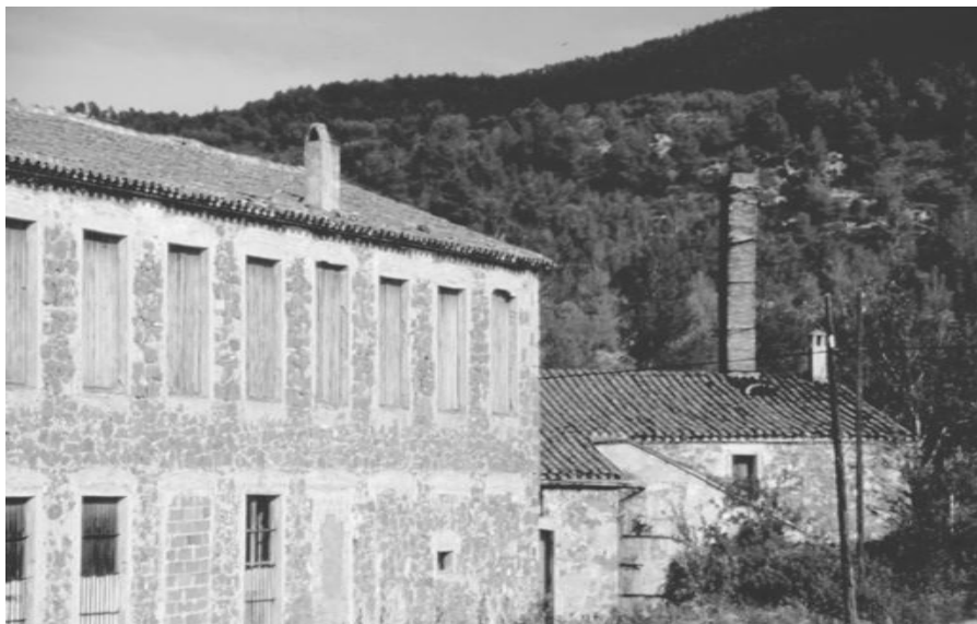
Al fons, l'edifici paperer, amb la xemeneia de secció quadrangular. En primer terme, la nau fabril (1987)
