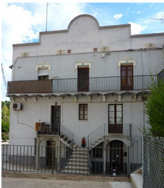
Façana frontal de l'edifici principal, amb escales i galeries exteriors d'accés als habitatges (2013)
