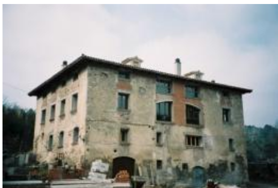
L'edifici en obres de transformació (2005)
