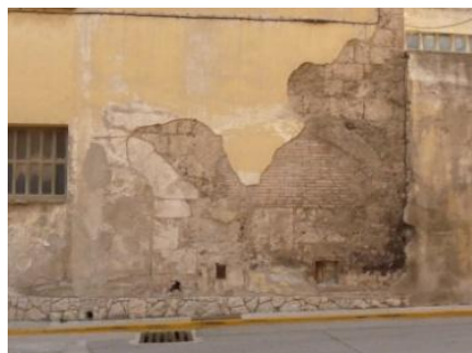
A l'esquerra, vestigis de dovelles del portal original. A la dreta, fragment de maó i pedra de turo en els caires. (2013)
