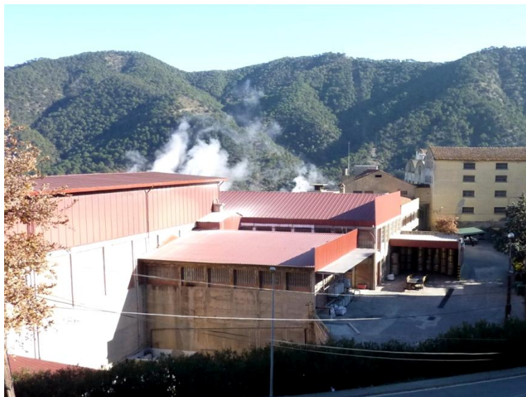
Al fons a la dreta, Cal Castells.
