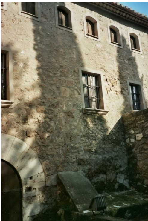
Vista parcial de la façana principal, amb el portal d'accés (2004)
