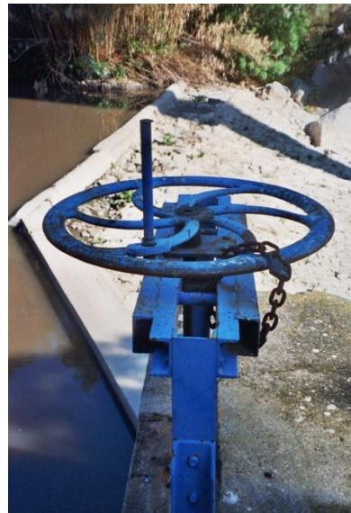
Mur de contenció i mecanismes hidràulics (2005)
