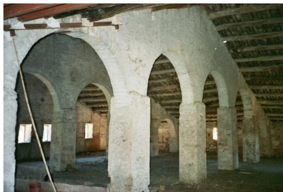
Pilars i arcs de pedra del nivell superior (2004)
