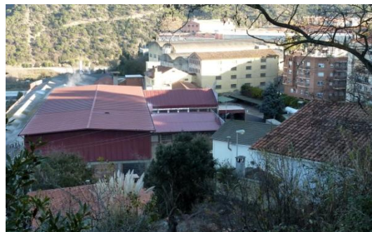
Els tres establiments paperers: a la part esquerra, un edifici allargat de color gris en el lloc de Cal Sapara, al centre, noves construccions de Cal Mata, al fons, Cal Castells. (2013)
