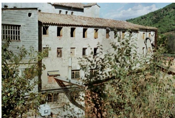
Façana lateral de Cal Tortet i part d'ampliacions adjuntes (2004)
