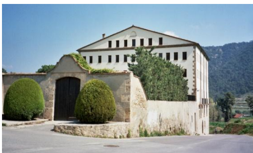
Portal superior d'accés a l'habitatge (2002)
