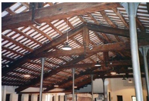
Bigam de fusta i columnes de ferro del pis superior
