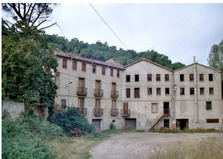
Els tres cossos edificats segueixen el traçat en angle de l'antic camí Ral que, a partir d'aquí, pren ara el nom de carrer de La Torre Baixa (2005)
