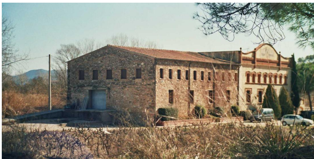
Façanes frontal i lateral esquerra (2005)
