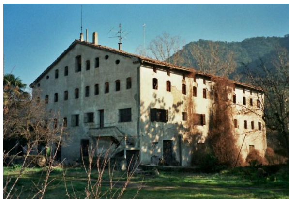
Façanes frontal i lateral de l'edifici principal (2004)
