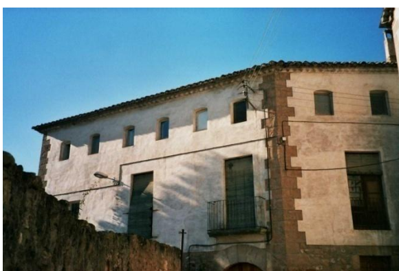
Angle de l'edifici amb els caires de pedra de turo (2004)
