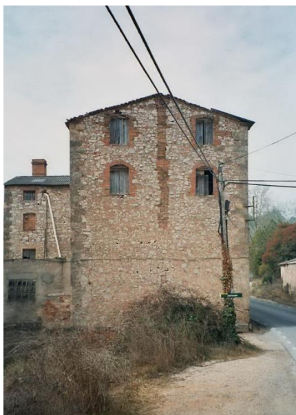
Paret lateral de pedra i maó (2005)
