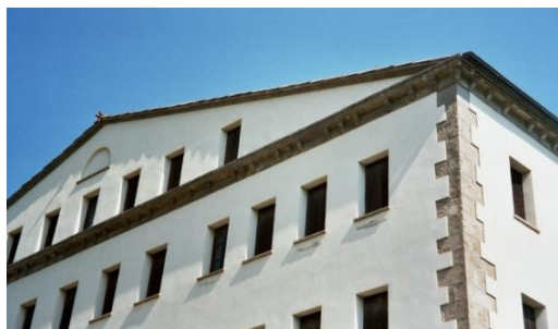
Caires de pedra de turo i cornisa superior (2002)
