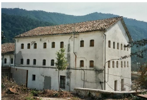
Part superior de l'edifici, amb l'entrada de l'habitatge tapiada (2004)
