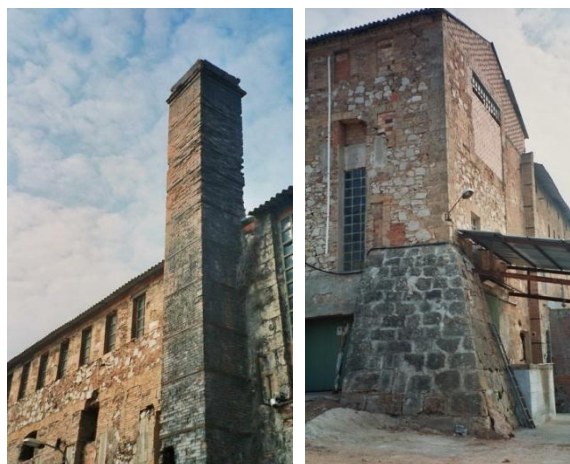
Detall de la xemeneia i d'un contrafort (2006)
