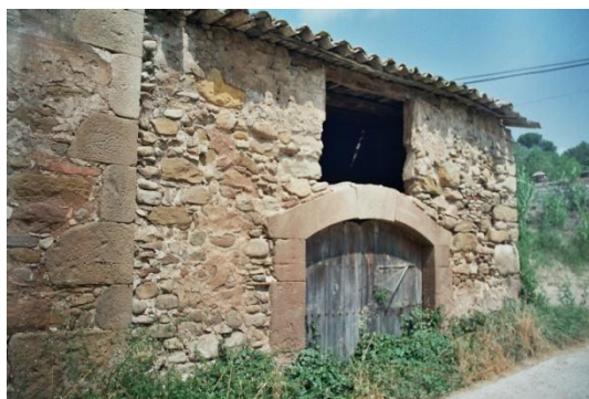
Portal d'entrada del molí fariner adossat
