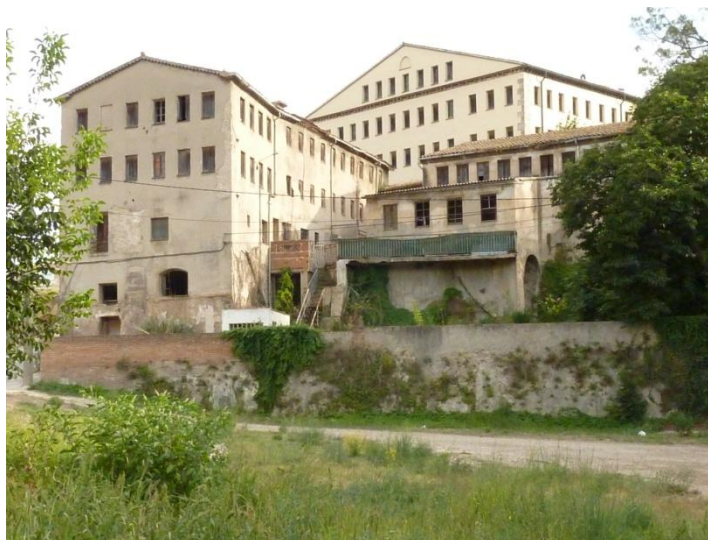
El molí del Pau Vidal apareix en primer terme, amb les dues construccions fent angle. (2011)
