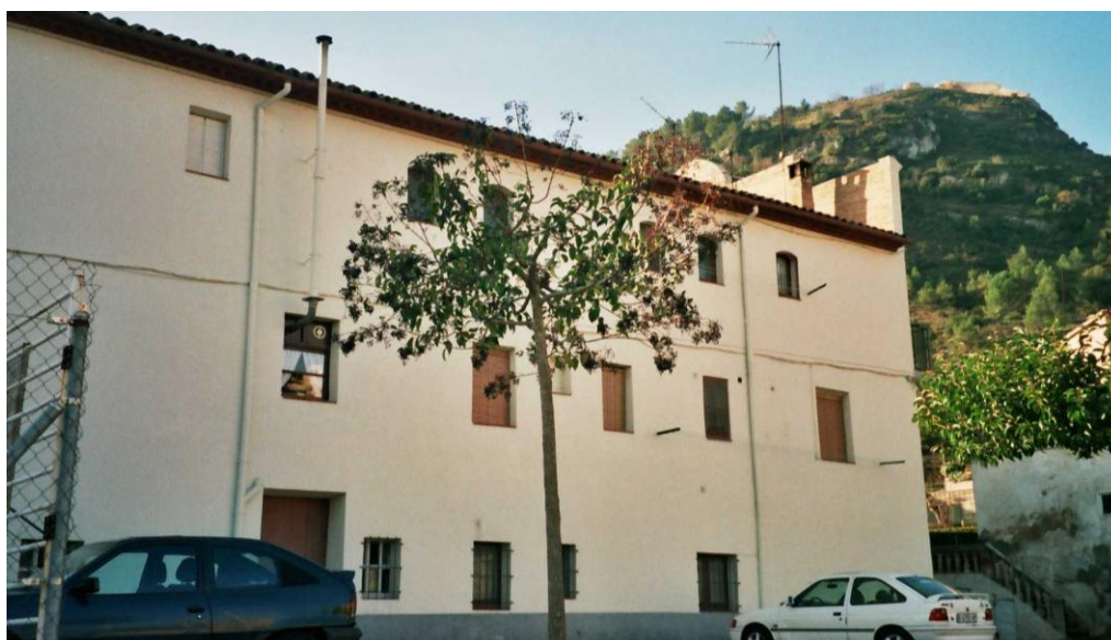
Façana lateral de l'edifici principal (2004)
