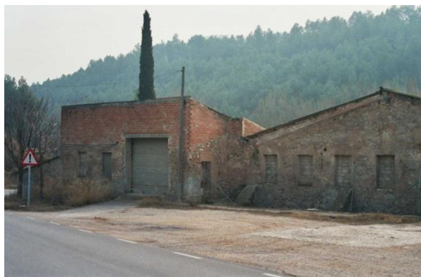
Cara posterior adjunta a la carretera (2005)
