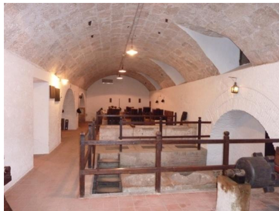
Nivell inferior: volta de turo i bateries de piles. (2010)
