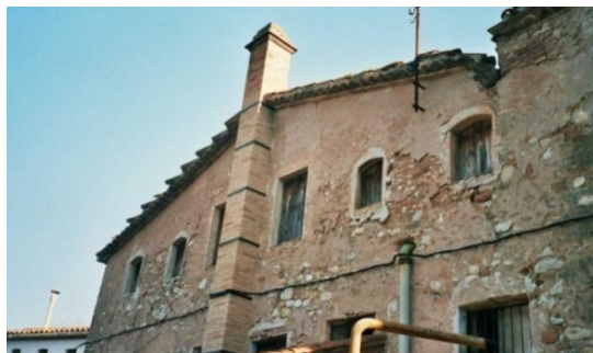
Detall dels materials de construcció (2004)
