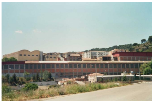
Les noves construccions distribuïdes seguint la mateixa disposició (finals s. XX)
