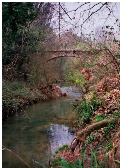
Pont sobre la riera de Carme (2004)
