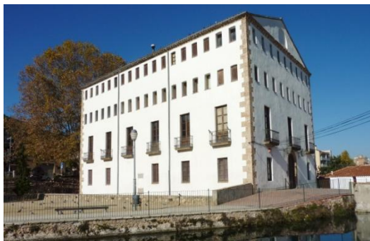
Façana frontal i lateral sud (2013)
