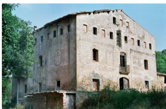
L'edifici abans de la seva restauració (2004)
