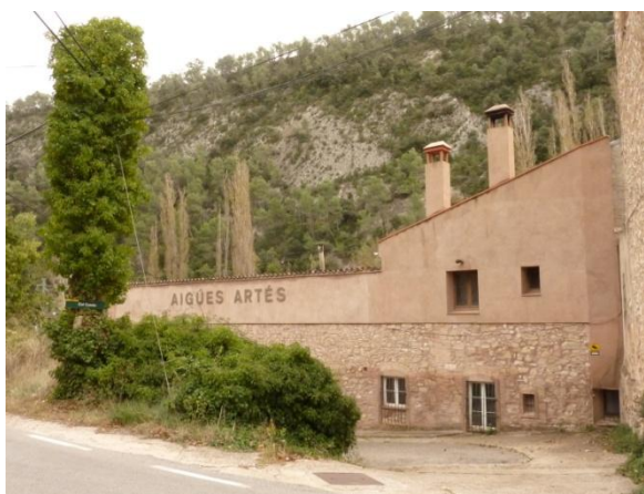
Vista frontal i accés a les instal·lacions de "Aigües Artés" (2013)
