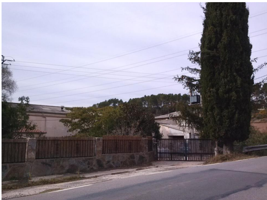
Vista parcial amb la tanca que bordeja l'accés a l'habitatge (2013)
