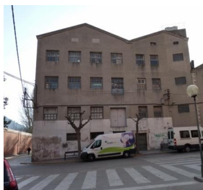
Façana frontal a l'actual carrer Dr. Fleming (2013)
