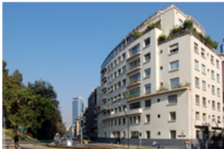
figura 43. Edificio Santa Lucía "El Buque"
