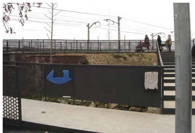
Vista de la passera principal que connecta el nucli antic de Sant Boi amb el riu Llobregat. Font: Emma Lozano
